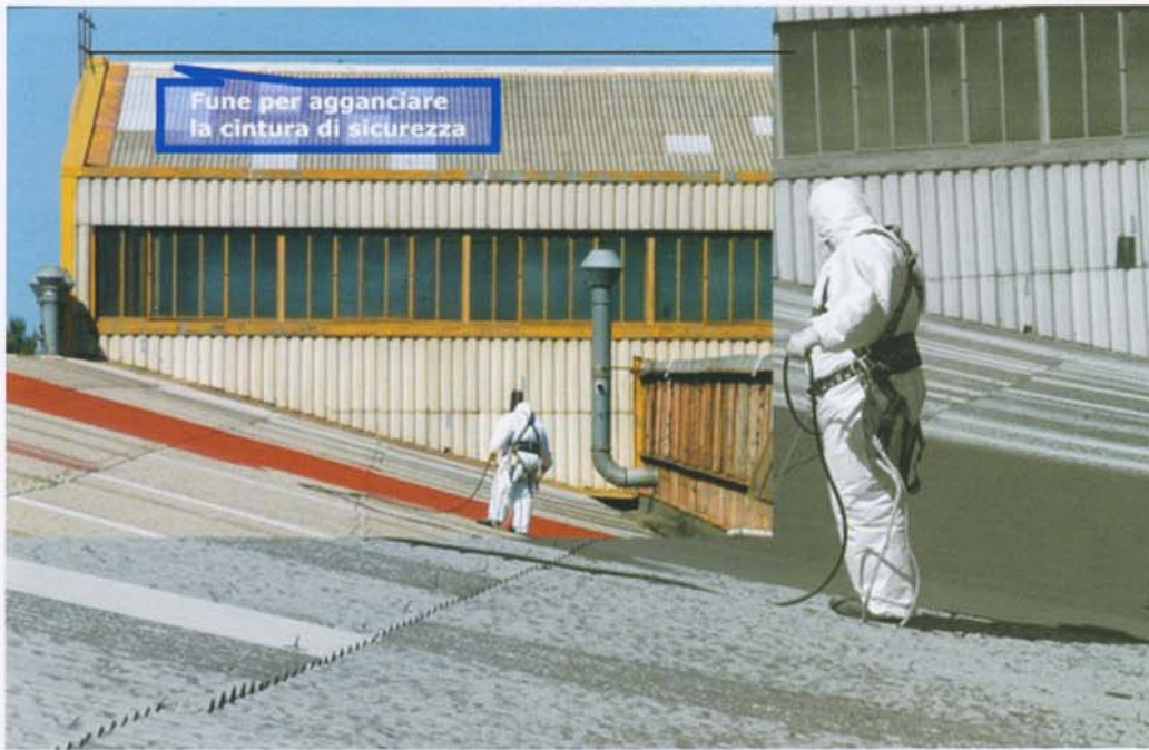
Immagine 17 - Lavori in quota, sul piano di copertura: Segnaletica di sicurezza rivolta agli addetti ai lavori in quota ed agli assistenti agli stessi (lavori di incapsulamento di lastre di amianto).
